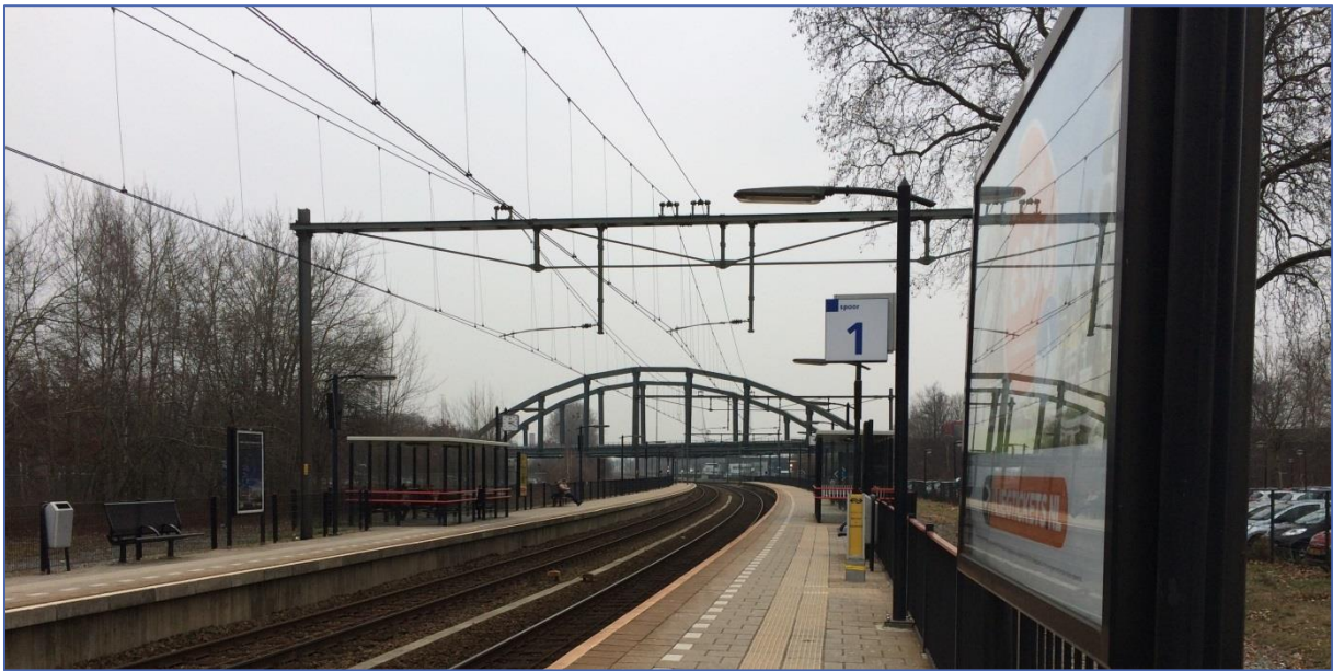
Figuur 21 – Station Beek-Elsloo , een inmiddels langlopend stationsproject
